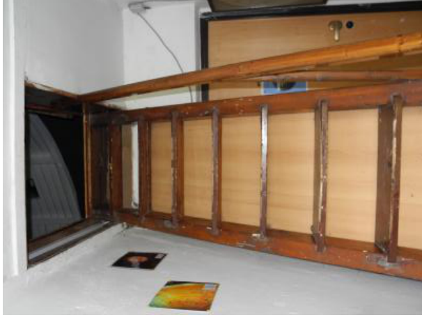
Obr. 12 — Schody pod kopuli.
