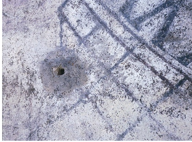
Obr. 6 — Otvor po chybějícím ukazateli levých západních hodin.
