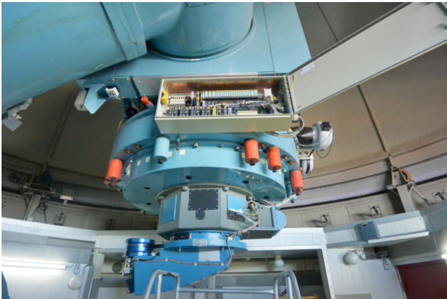
Obr. 2 — Jedna z komponent nově osazeného průmyslového řídicího systému dánského dalekohledu.
