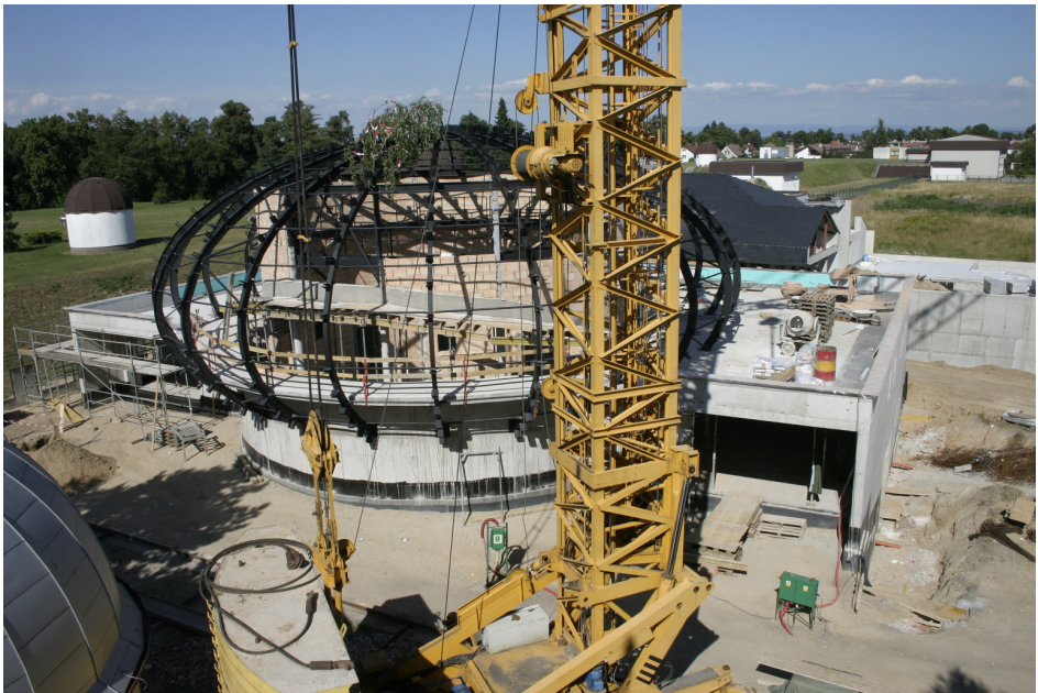
Obr. 4 — Stav stavby 22. července 2013, kdy byla vztyčena nosná konstrukce elipsoidu.
