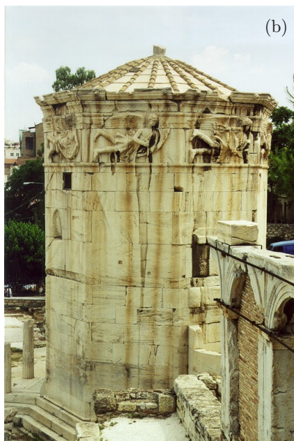
Obr. 12 — Věž větrů v římské agoře pod Akropolí v Athénách, vystavěná Andronikem z Kyrrhesty v letech 50–41 př. n. l. V jejím interiéru fungovaly vodní hodiny (klepsydry), na osmi vnějších zdech orientovaných do základních světových stran je umístěno osmero slunečních hodin s kolmými ukazateli. Na všech číselnících jsou značeny temporální hodiny. (a) Pohled od SV, (b) od JZ, (c) od S, (d) od JV. Foto Martin Šolc (2003).
