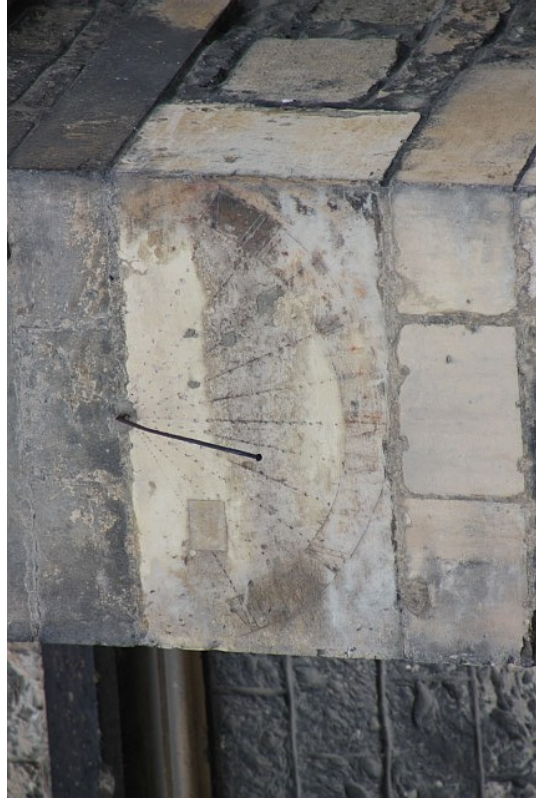
Obr. 1 — Sluneční hodiny na kostele Sv. Mikuláše v Lounech (ev. č. LN 8). Foto Pavel Uhrin.
