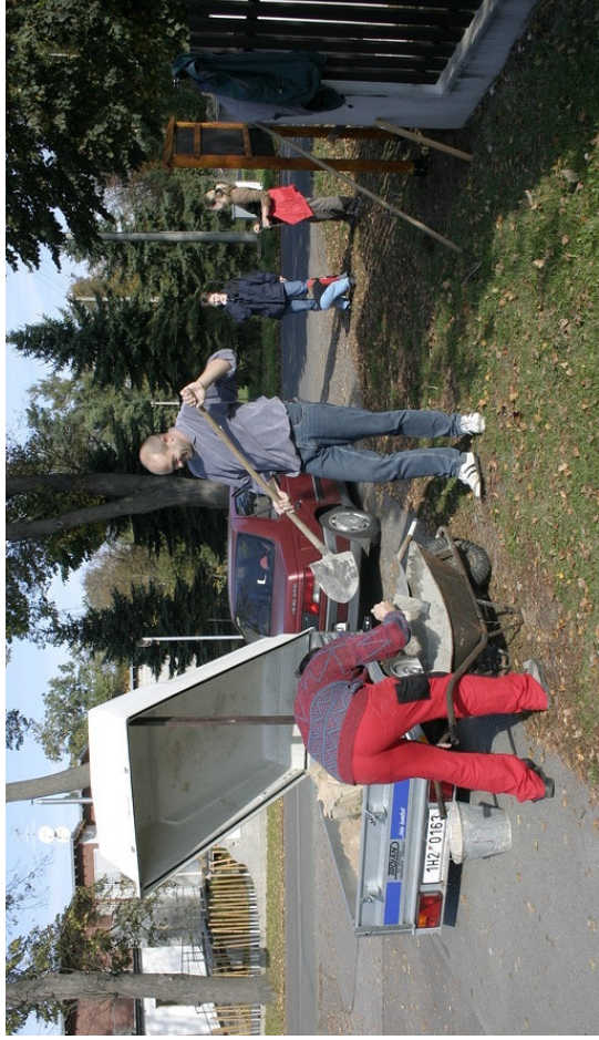
Obr. 16 — Betonování sloupků Galaktické stezky 7. 10. 2007.
